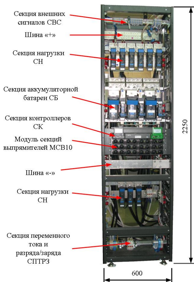
Рисунок 3.4 - Расположение основных частей ЩТР-5
