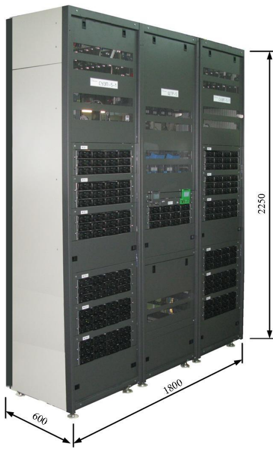
Рисунок 3.2 - Внешний вид ЭПУ на260 кВт: СУЭП-5 48/2400 (60/2200)-7272-1 СУЭП-5 48/2400 (60/2200)-7272-2 ЩТР-5 5000+12.12
